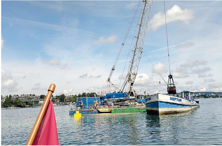
Anfang Woche fanden Höhe Rote Fabrik Testschüttungen statt. (Bild: nic.)
